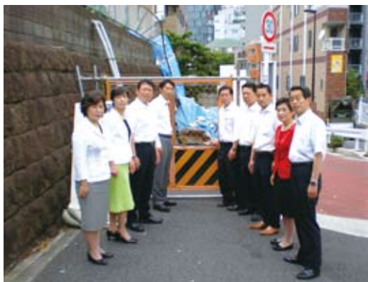
擁壁の崩壊現場を視察
